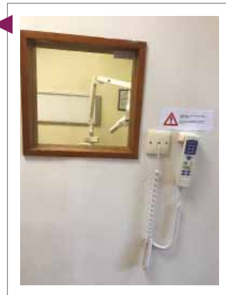
圖 21. 示工作人員可從防輻玻璃窗觀察受檢者。防輻玻璃吸收了雜散輻射。
