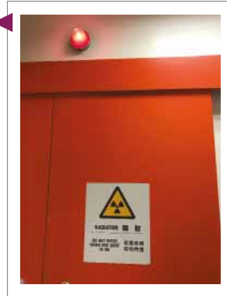
圖 20. 示管控區域的警示燈顯示為紅燈時禁止進入該攝片室。
